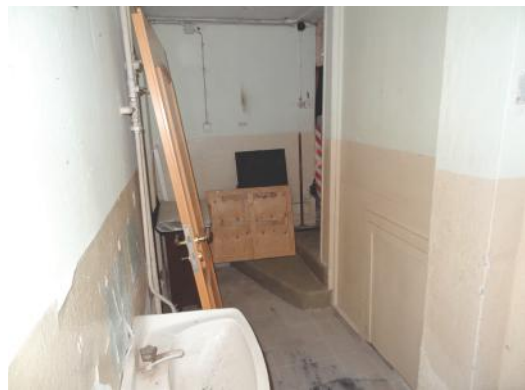
06 Ehemaliger Sanitärbereich im Anbau
