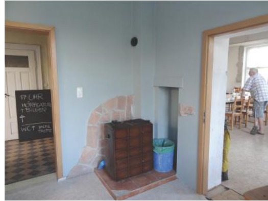
02 Küche mit Zugang zum Flur und zum Veranstaltungsraum im EG
