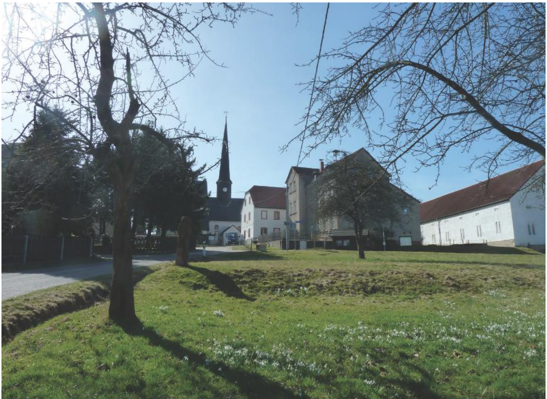
Blick auf das Ensemble Kirche - Kantorat - alte Dorfschule
