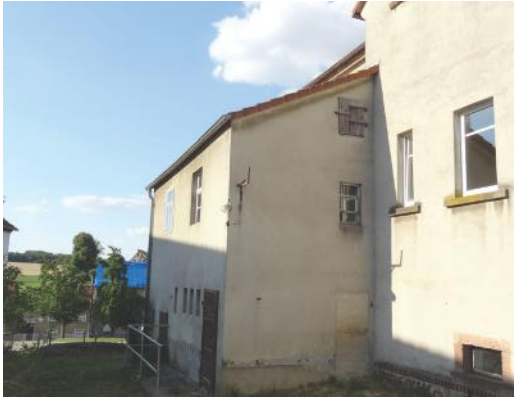
01 Rampe Hintereingang Anbau
