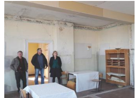
Erste Gebäudebesichtigung am 16.03.2017
