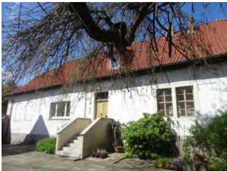
Das ehemalige Pfarrhaus in Ummendorf, Landkreis Börde in Sachsen-Anhalt vor der Sanierung, Foto: LEIHK gGmbH
