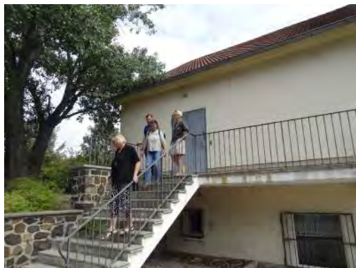
05 Treppe und Laubengang auf der Westseite
